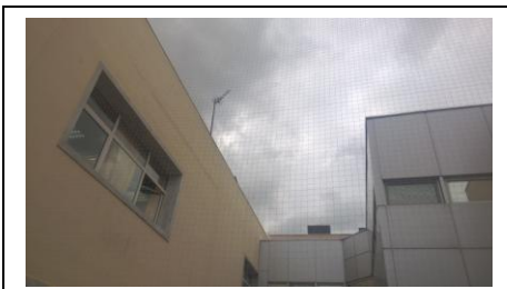
Κλωβός (δίχτυ) αποτροπής πρόσβασης πτηνών στις κτηριακές δομές του Βενιζελείου
