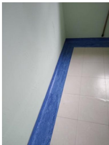
Πλήρης ανακαίνιση Μονάδας Τεχνητού Νεφρού
