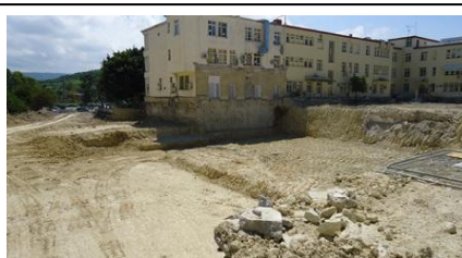
Μεταφορά αρχαίου ρωμαϊκού δρόμου, για τις ανάγκες της νέας πτέρυγας
